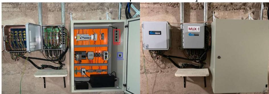
FIGURA 4 – Equipamentos de coleta de dados e comunicação instalados
